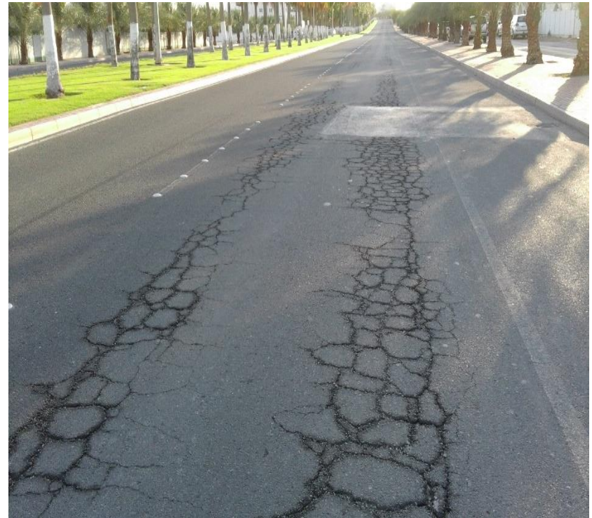
Усталостное растрескивание в Катаре
