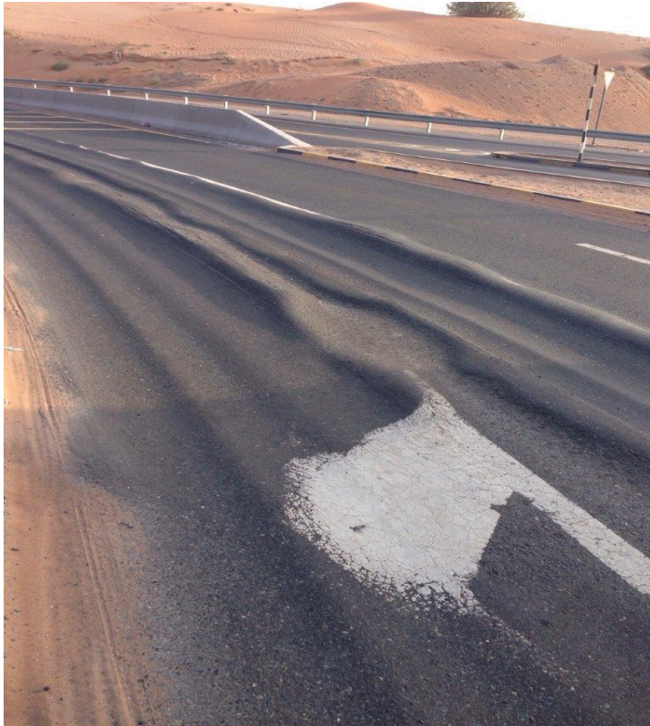
Колееобразование в ОАЭ
